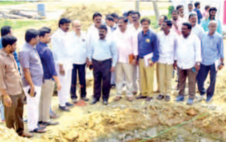
జగ్గయ్యపేట వద్ద నిర్మిస్తున్న హైవే-ఆర్టీసి బస్టాండ్ పనులు పరిశీలిస్తున్న సామినేని ఉదయభాను
